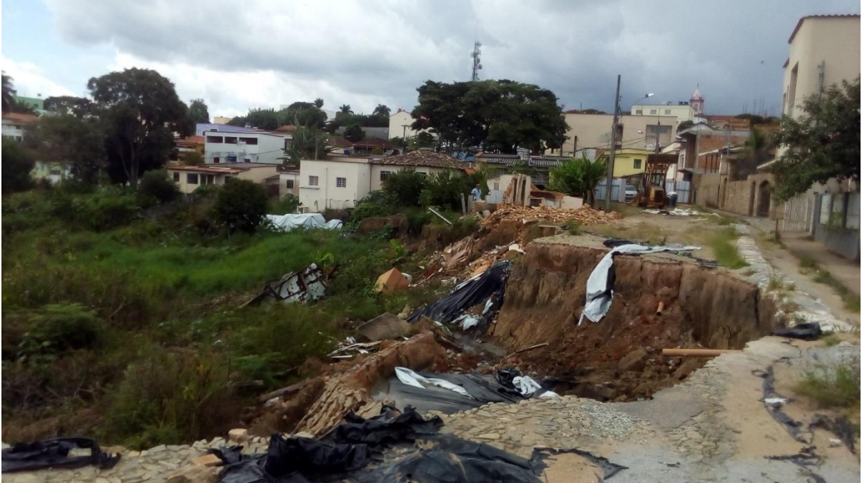
Figura 1 Deslizamento de terra na Rua Joaquim Marques da Silva. Fonte: autor
